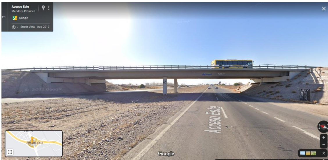
Figura 2.14: Vista en Puente típico de la clase VCH-SATM.
