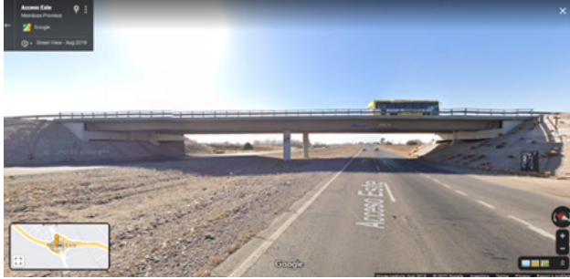
Figura 2: Puente Acceso Este a la Ciudad de Mendoza, RN 7 (Fuente: Google Maps).
