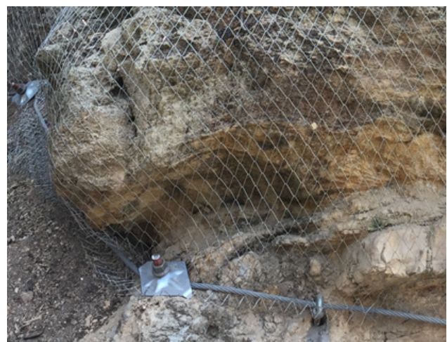
Figura 9: Sistema de contención de malla flexible y anclajes aplicado a ladera inestable en Castello di San Terenzo, Italia. Geobrugg AG (2017).
