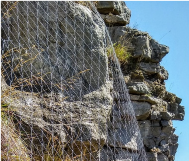
Figura 10: Sistema de contención de malla flexible y anclajes aplicado a ladera inestable en Mar del Plata, Argentina. Geobrug AG (2020).
