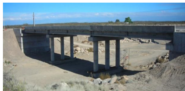
Figura 1: Puente sobre el Arroyo Tierras Blancas, RN 40.
