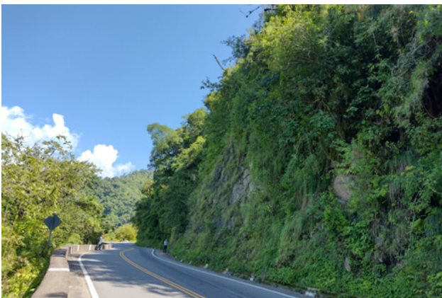
Figura 6: Ladera expuesta en RP N°307, kilómetro 28, configuración típica de caminos de montaña fundados en corte de ladera. (2023).
